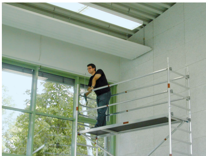
Bild 8. Leckageortung an höher gelegenen Bauteilen mit Hilfe des Rollgerüsts (Foto: IngBEU)
