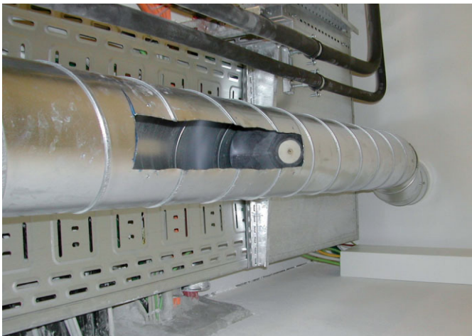
Bild 5. Abdichtung der Leitung einer Lüftungsanlage
