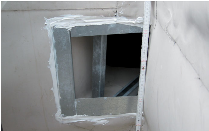
Bild 3. Rauchabzugsöffnung im Fahrstuhlschacht
